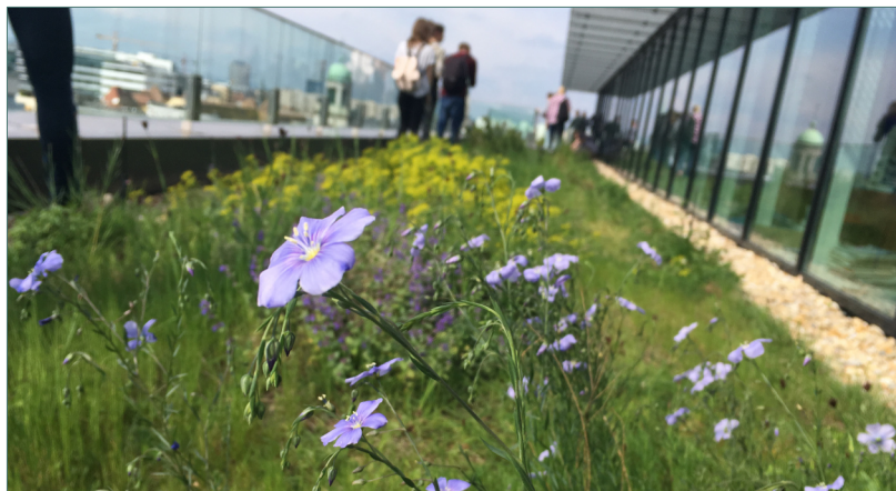
Semi-intensive Dachbegrünung in Graz
