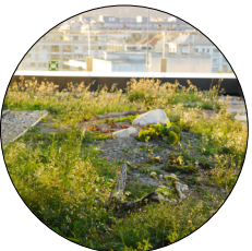
semi-intensive Dachbegrünung
