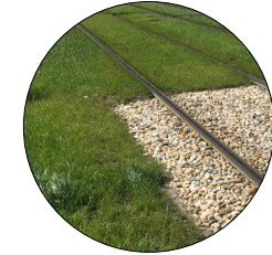
begrünte Gleisanlage
