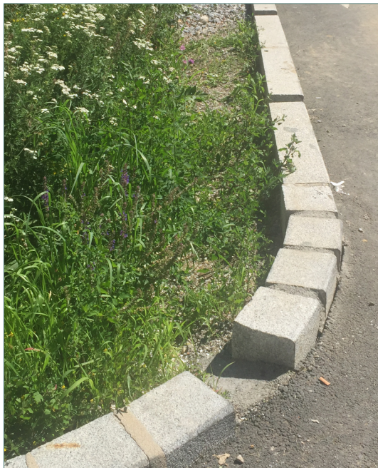
Einleitung durch punktuell Öffnung des Bordsteins
