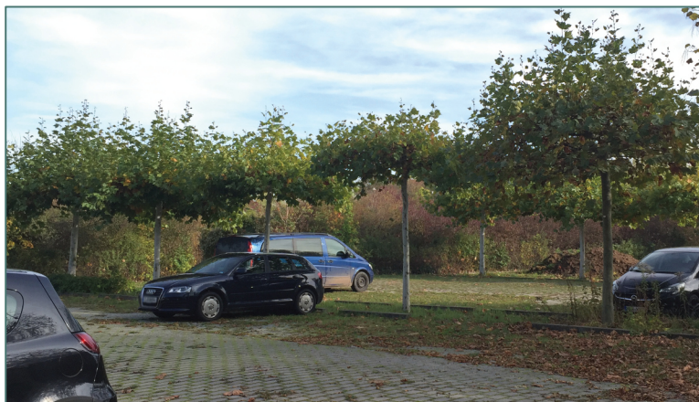
Beschatteter, versickerungsfähiger Parkplatz zur Verbesserung der Temperaturverhältnisse
