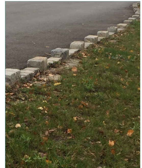
Einleitung durch niveaugleich eingesetzte Pflastersteingruppen
