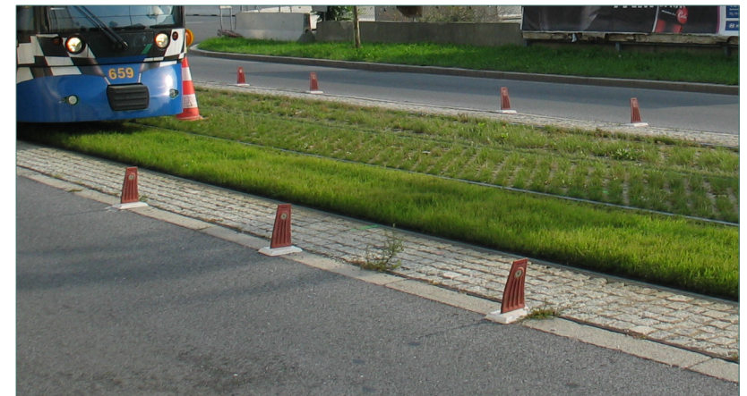
Begrünte Gleisanlage in Graz
