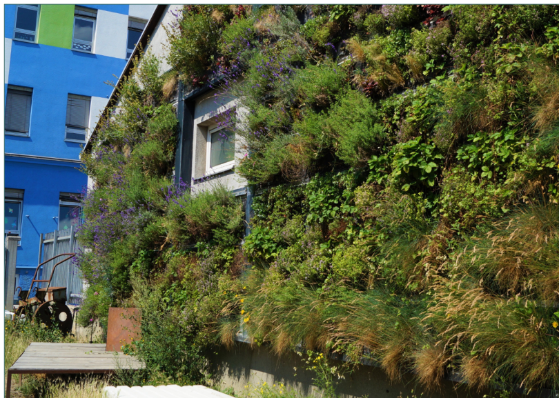
Modulare Fassadenbegrünung (LivingPANELS der NatureBASE)
