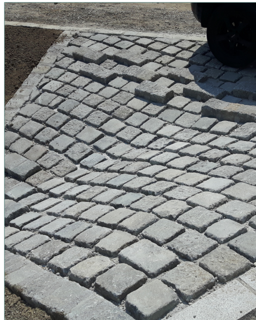
Entschleunigung des Oberflächenwassers
